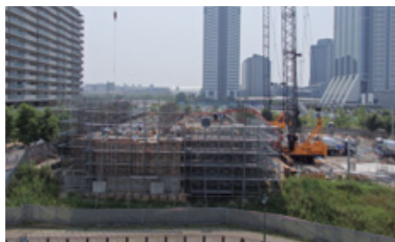
東棟から見た新校舎建設現場
