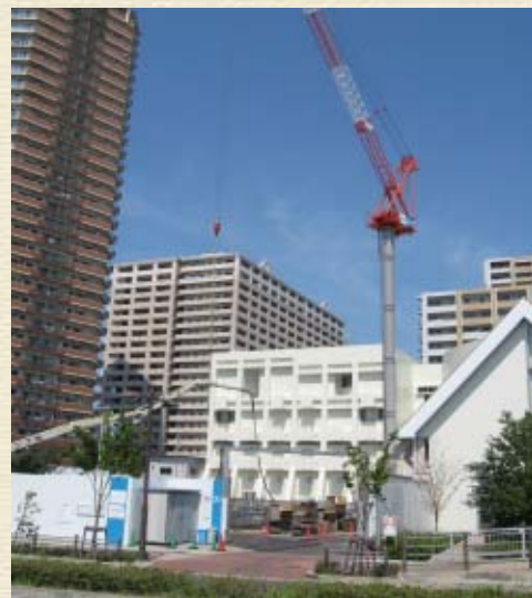
建設が進む看護棟。後ろが本館。右が『メディ・カフェ』。
